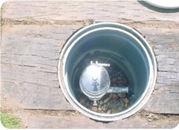
枕木を敷いてある場所へ設置
