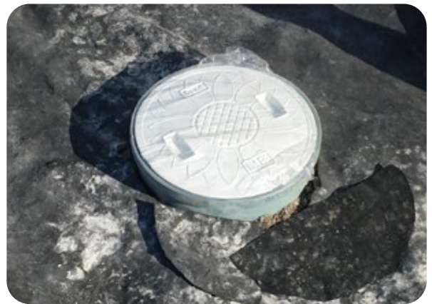
仕上がりは黒い防草シートの上に砕石を敷きます
