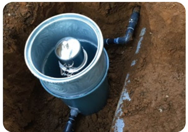
排水管を避けて水道配管を接続します
