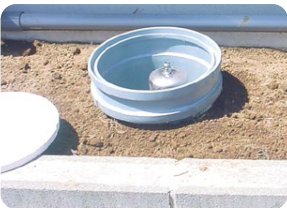
花壇の中へ設置 地中に排水管があるため少し地上へ出しています
